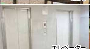
エレベーター
